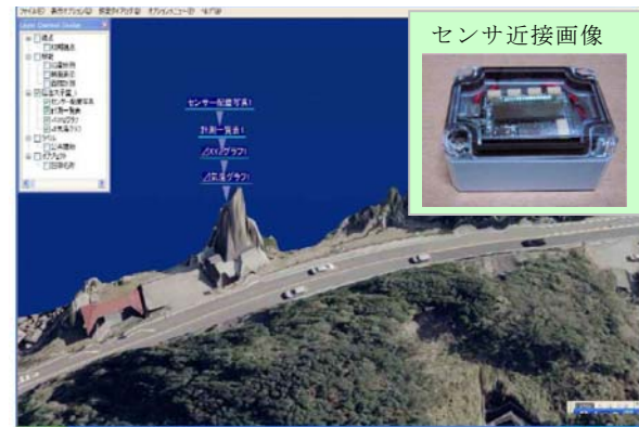
図－3 設置箇所の状況（3D-GIS 表示画面）
