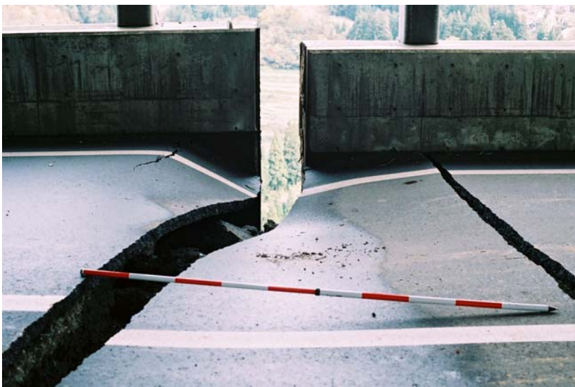
一般県道木沢相川線(川口町)
