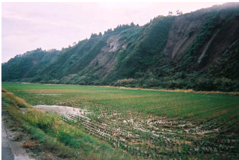
一般県道木沢相川線(川口町)
