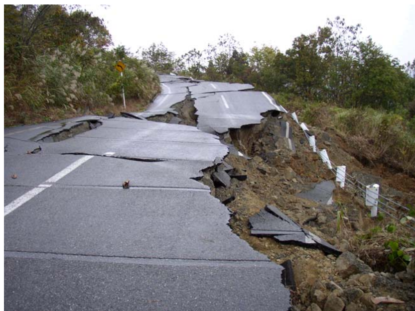
小千谷市池ヶ原 日本道路公団山本山トンネル付 近
