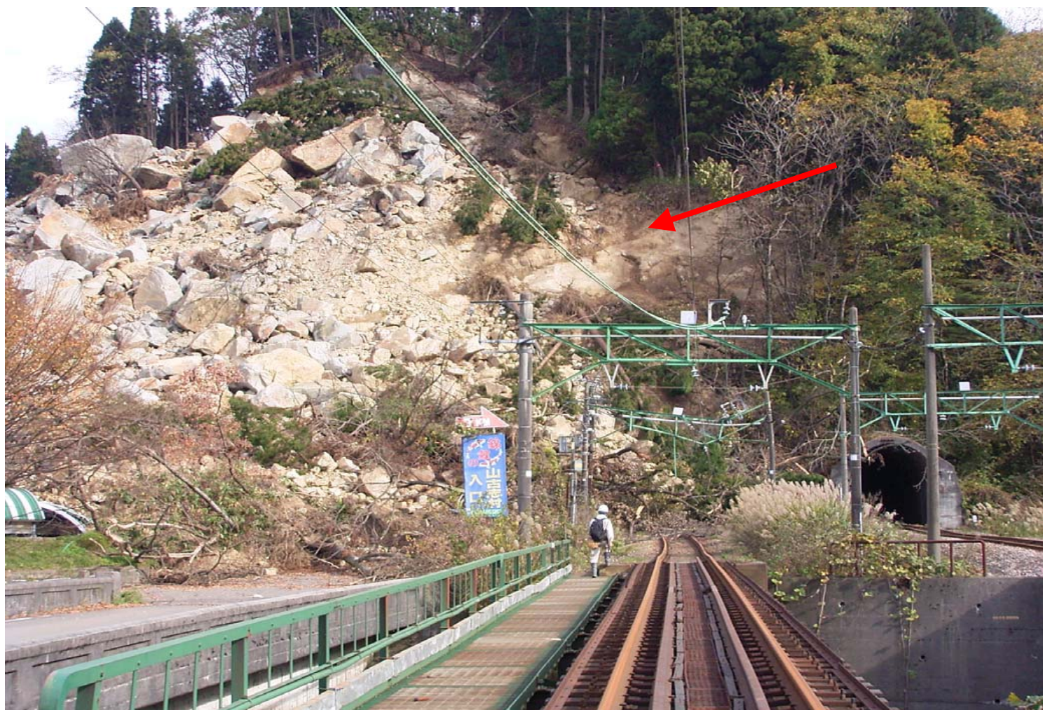
JR上越線 榎トンネル小千谷側坑口状況。 下り線(写真中央の線路)坑口は、上方斜面からの崩壊土砂により塞がれている。 写真右側坑口は上り線坑口。矢印は層理面方向。
