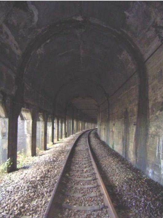
スノーシェッド内部の状況。
