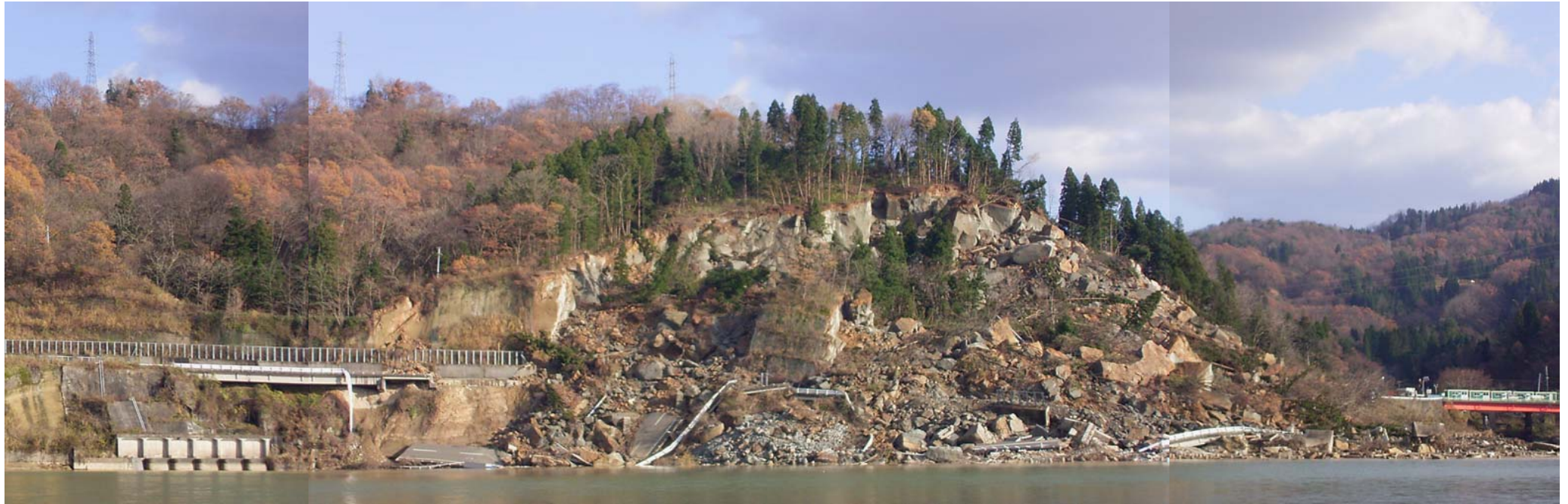
妙見～浦柄で発生した斜面崩壊跡
