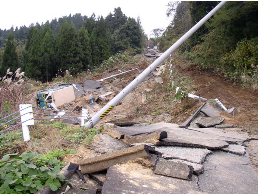
町道の崩壊現場(新幹線堀之内ト ンネル小千谷側坑口部付近)
