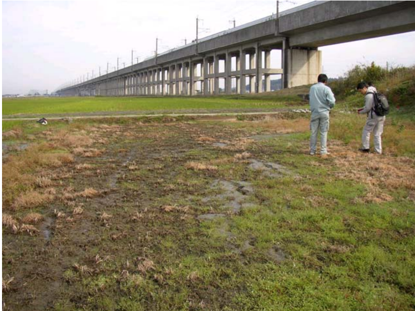
新幹線脱線現場周辺(長岡市)
