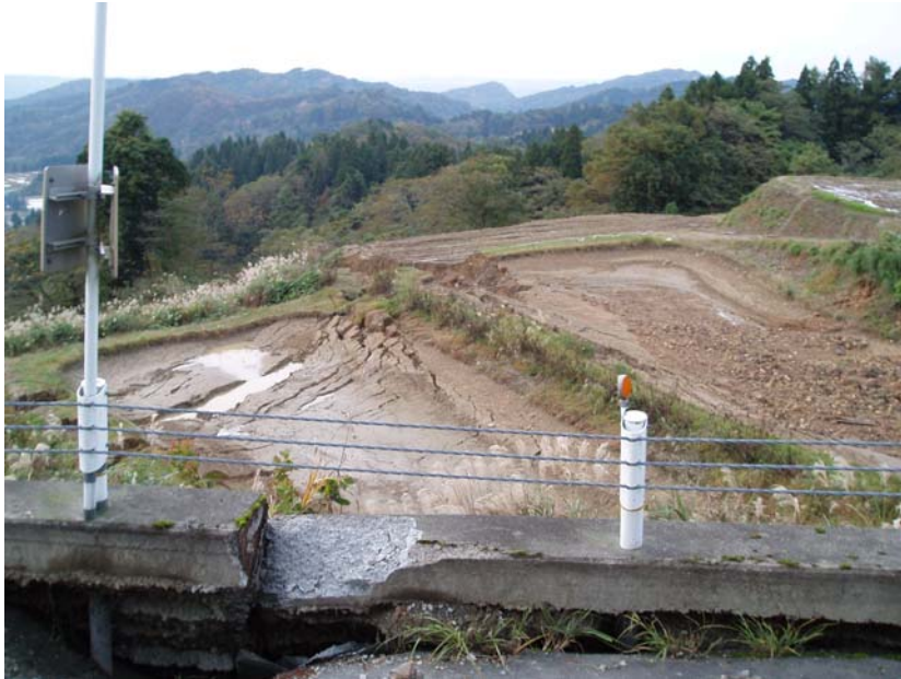
一般県道木沢相川線(川口町)
