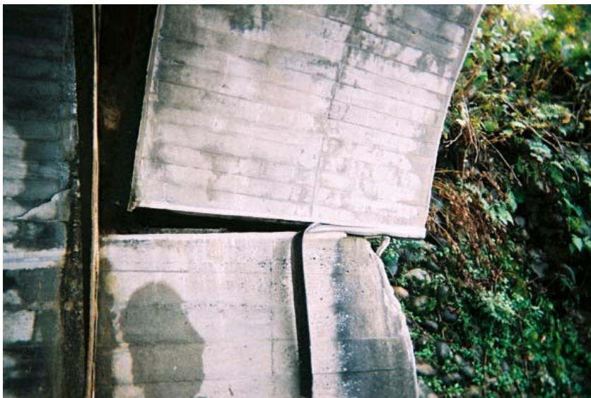
木沢隧道(川口町側坑口)側壁部
