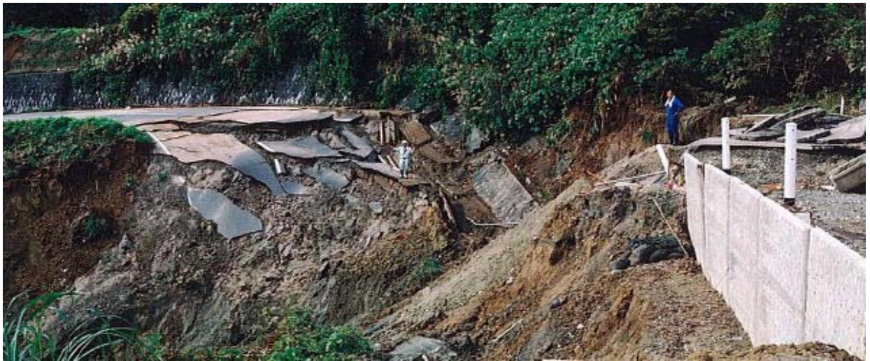
一般県道木沢相川線(川口町)
