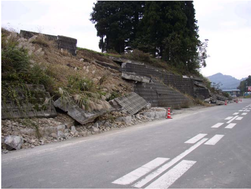
主要地方道小千谷十日町津南線 (小千谷市池ヶ原付近)
