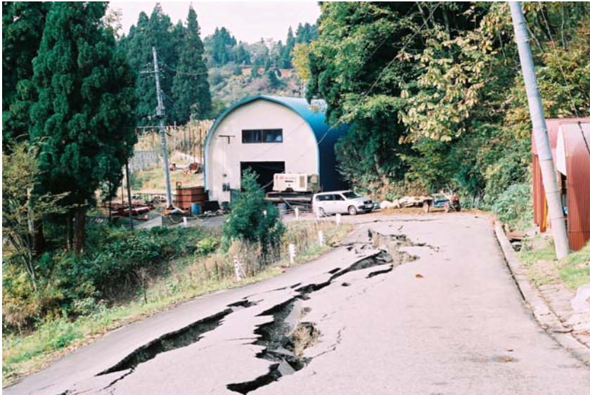
一般県道木沢相川線(川口町)
