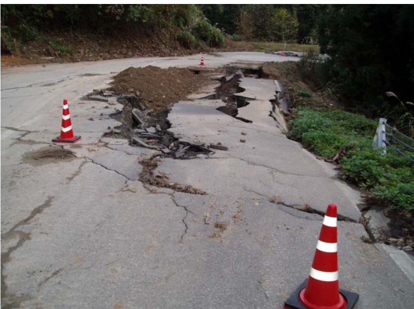
一般県道木沢相川線(川口町)
