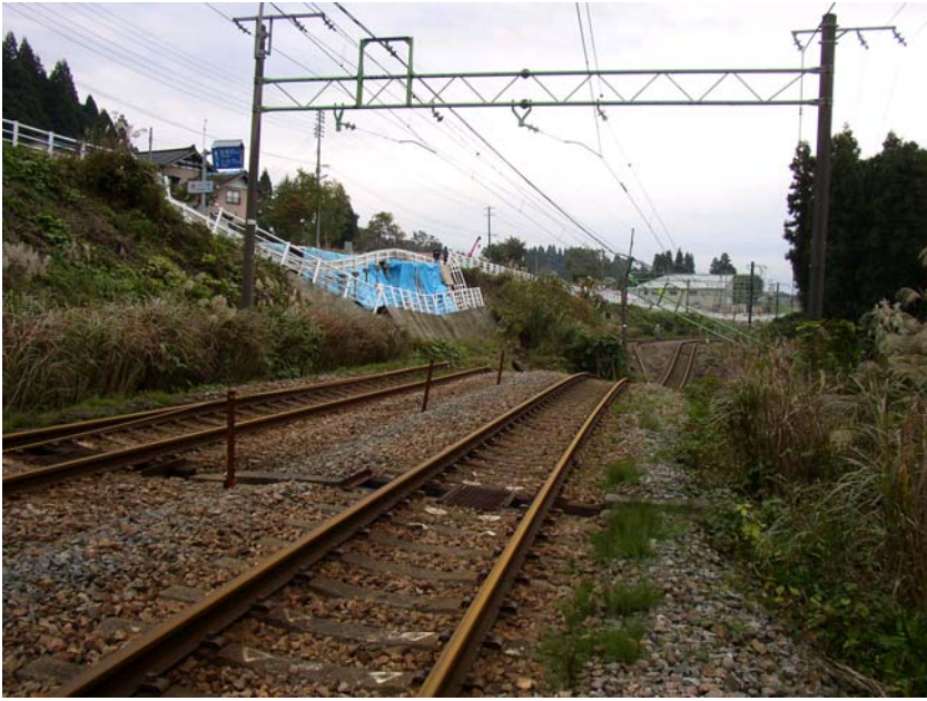
国道17号とJR上越線 (小千谷から越後川口 方向を望む)
