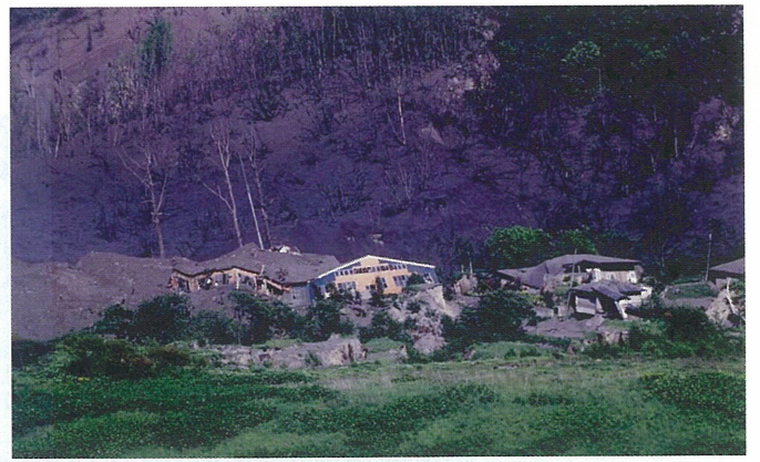
国道230号付近のわかさいも工場と噴火口 工場は、地殻変動による地盤隆起や、地割れ、噴石弾の直撃を受け、ぼろぼろである。
