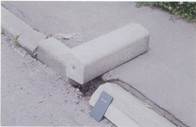
圧縮による縁石の跳ね上がり 80cmの縁石の空間は20cm程度まで圧縮されている。(虻田町高砂)
