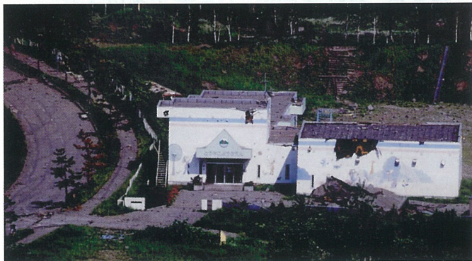
洞爺湖幼稚園と西山火口群 道道は亀裂が走り、幼稚園は噴石弾により多数の穴があき、壁が大きく崩壊している。国道には火口が形成され、見る影もない。
