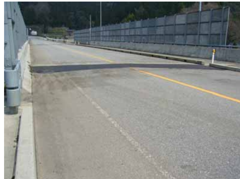
05 市ノ瀬跨線橋
