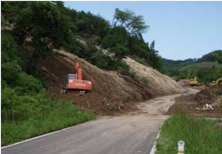
写真： 斜面崩壊による復旧状況
