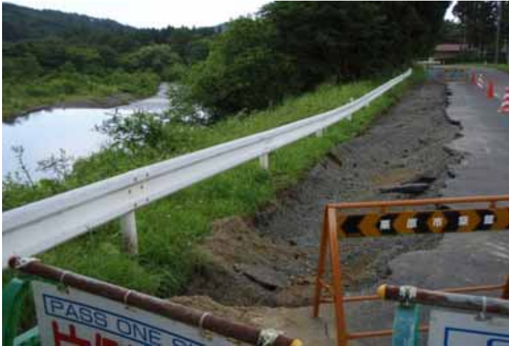
写真： 河岸部のすべり・陥没
