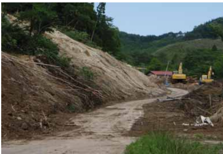
写真： 斜面崩壊による復旧状況
