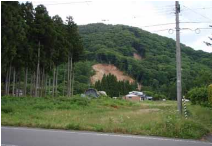
写真： 斜面崩壊(人家に影響無)
