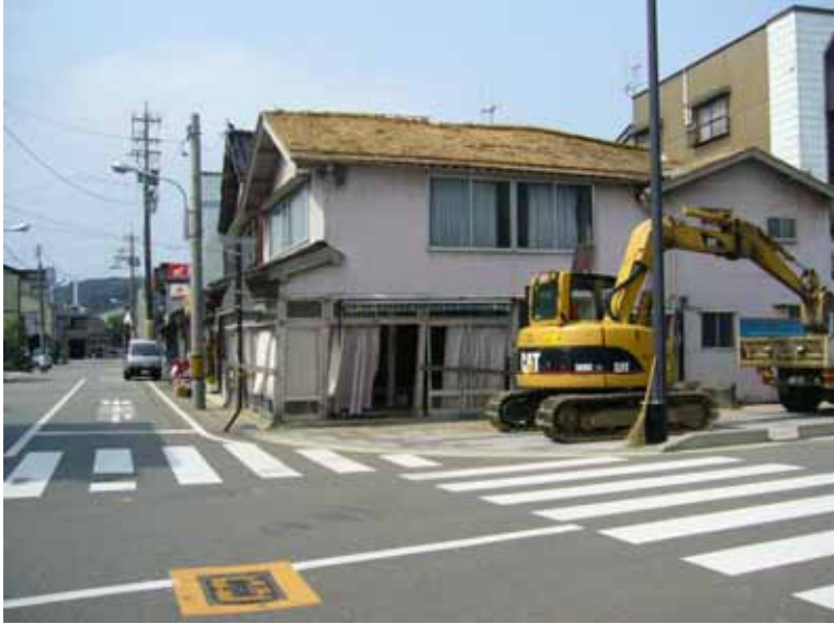
07 輪島市内変状-0
