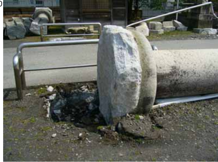
07 輪島市内変状-02
