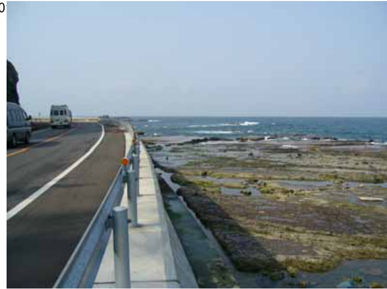
03 赤神法面崩壊-02
