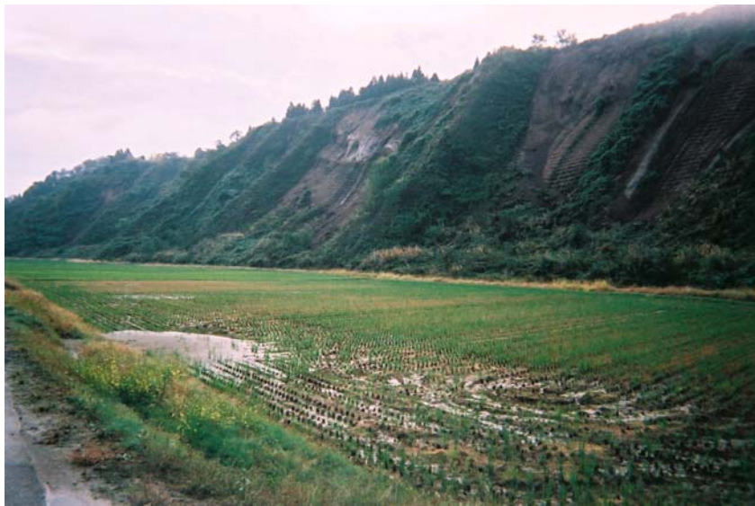
一般県道木沢相川線(川口町)
