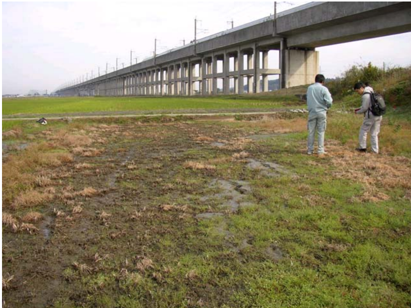
新幹線脱線現場周辺(長岡市)
