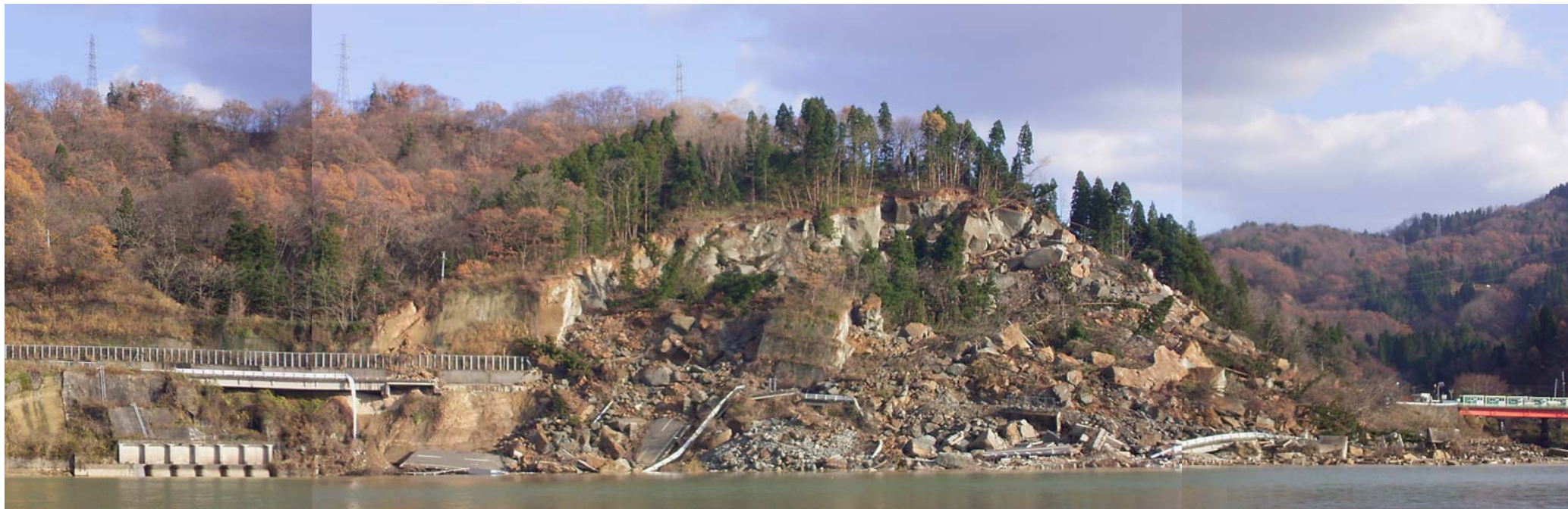
妙見～浦柄で発生した斜面崩壊跡
