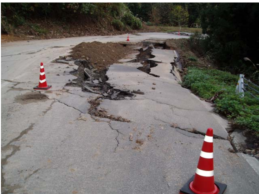
一般県道木沢相川線(川口町)
