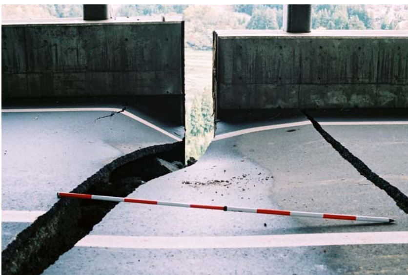
一般県道木沢相川線(川口町)
