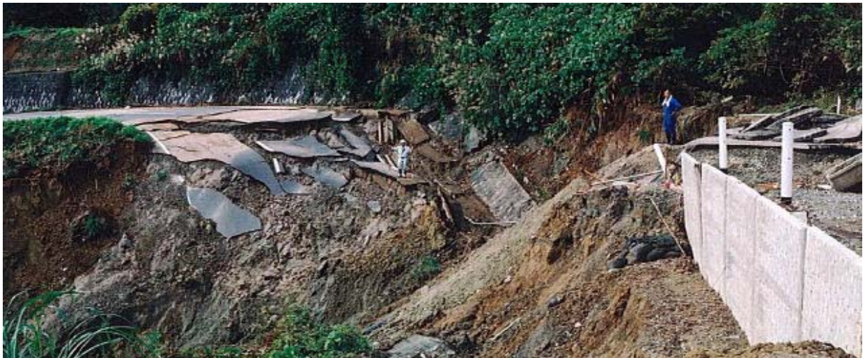
一般県道木沢相川線(川口町)
