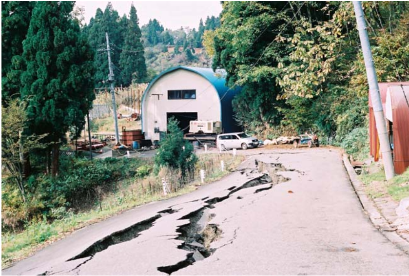
一般県道木沢相川線(川口町)
