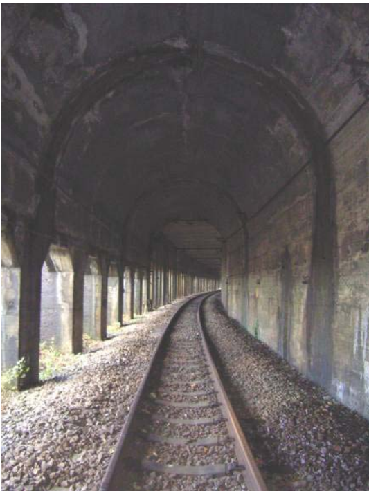
スノーシェッド内部の状況。
