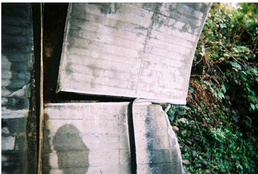
木沢隧道(川口町側坑口)側壁部
