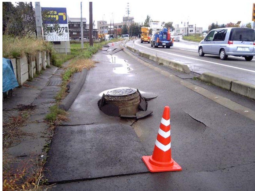
国道17号妙見町交差点付近の歩道
