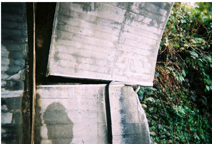
木沢隧道(川口町側坑口)側壁部
