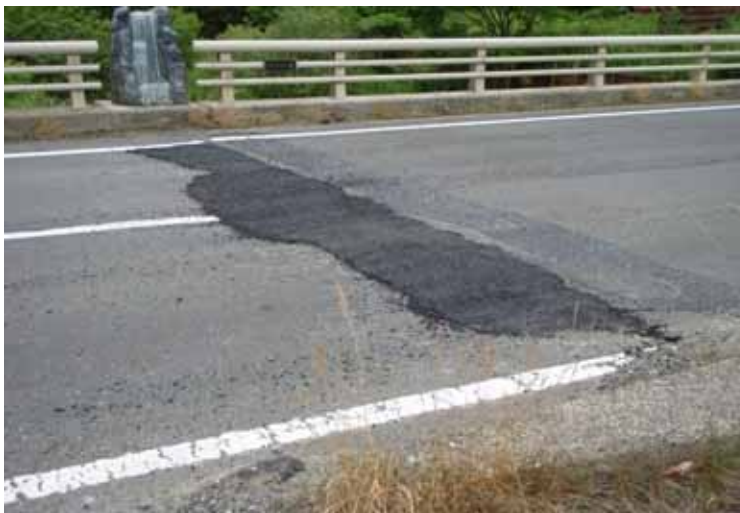
写真： 橋台部の段差の応急処置
