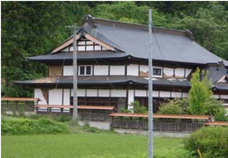
写真： 土壁使用部の崩落
