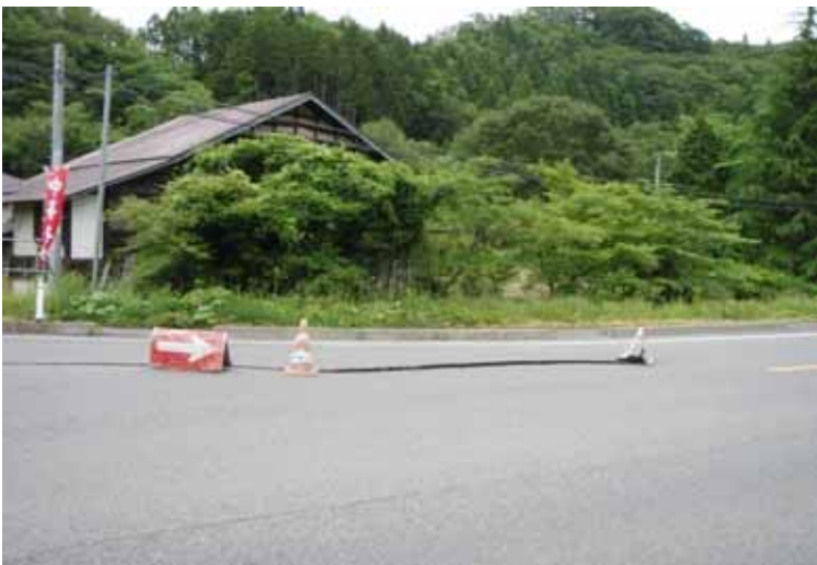
写真： 路面のクラック・段差
