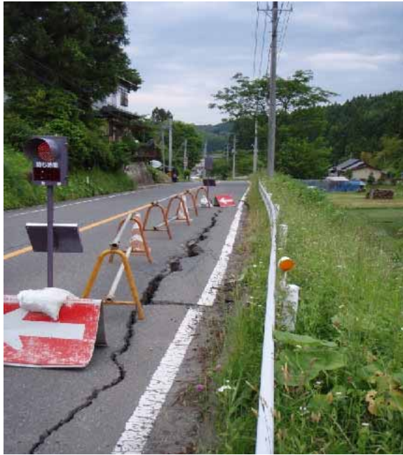
写真： 腹付け盛土の亀裂(すべり)
