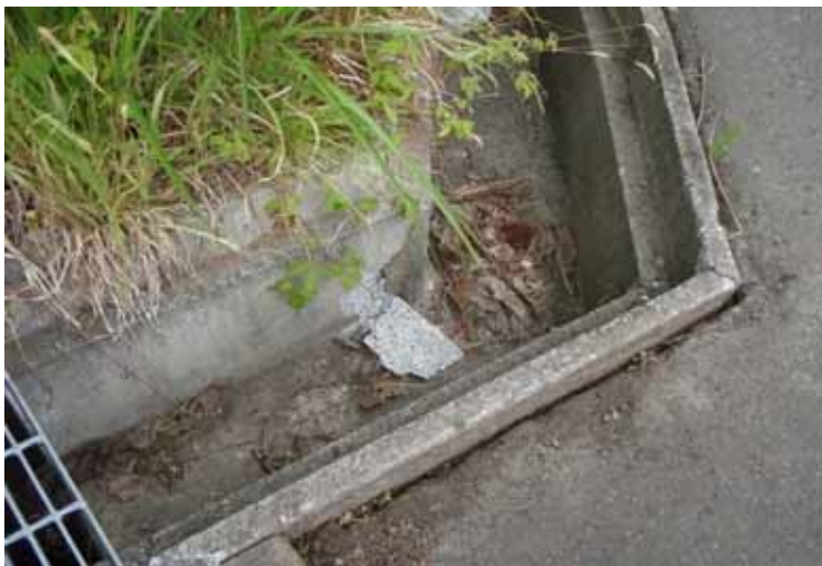
写真： 側溝の破損
