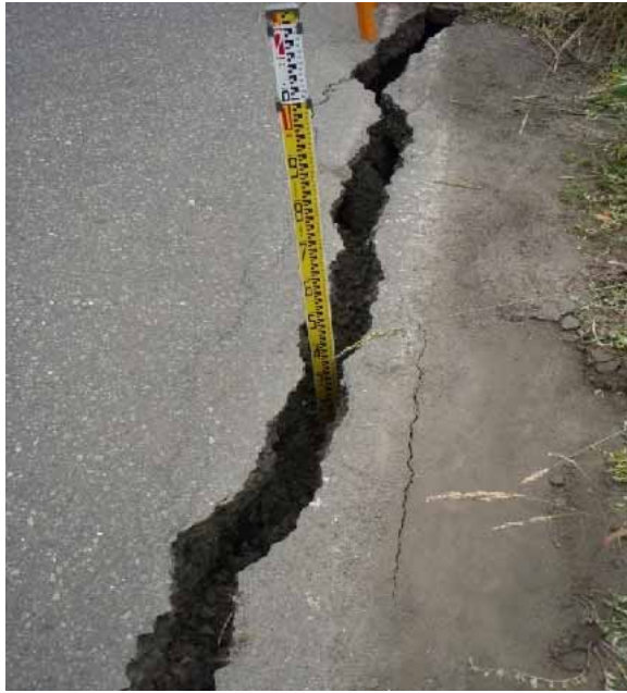
写真： 路面のクラック開口(深さ40cm)
