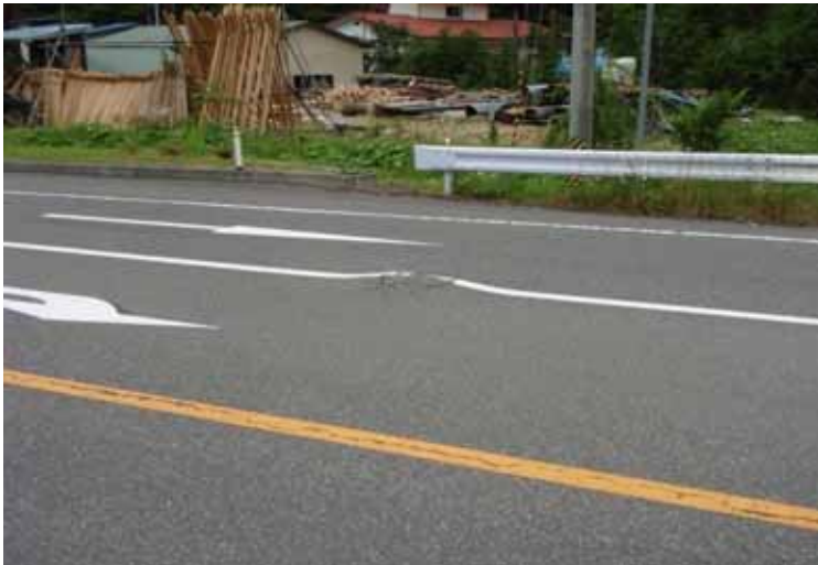
写真： 埋設物の浮きがり
