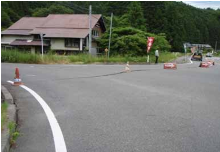
写真： 路面のクラック(開析谷)
