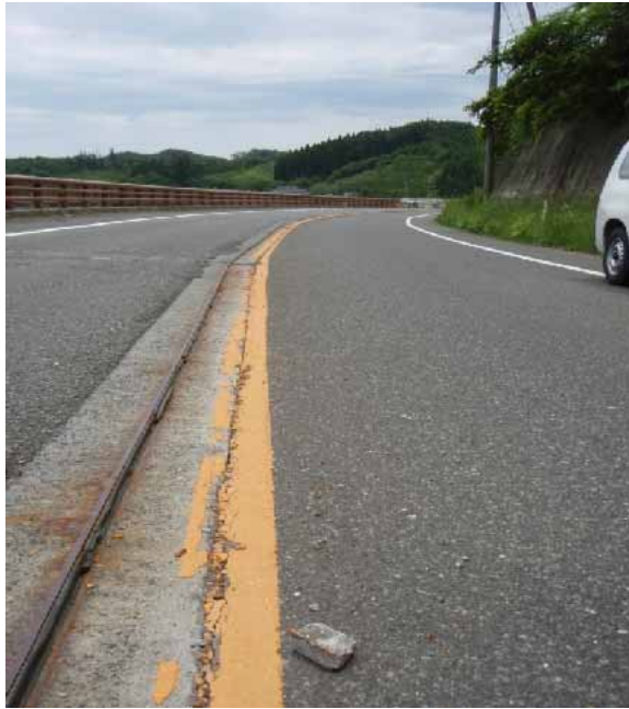
写真： 拡幅道路の境界部に段差発生
