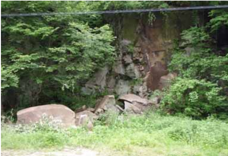
写真： 細粒砂岩の崩落箇所
