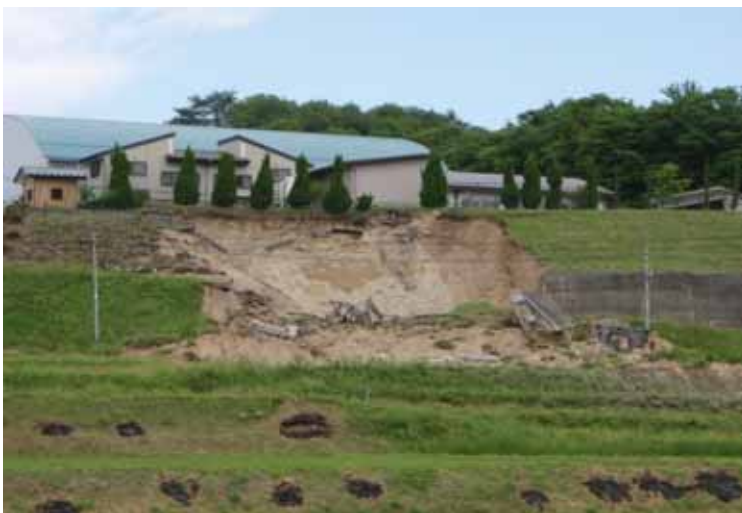
写真： 切土斜面の崩壊(小学校)
