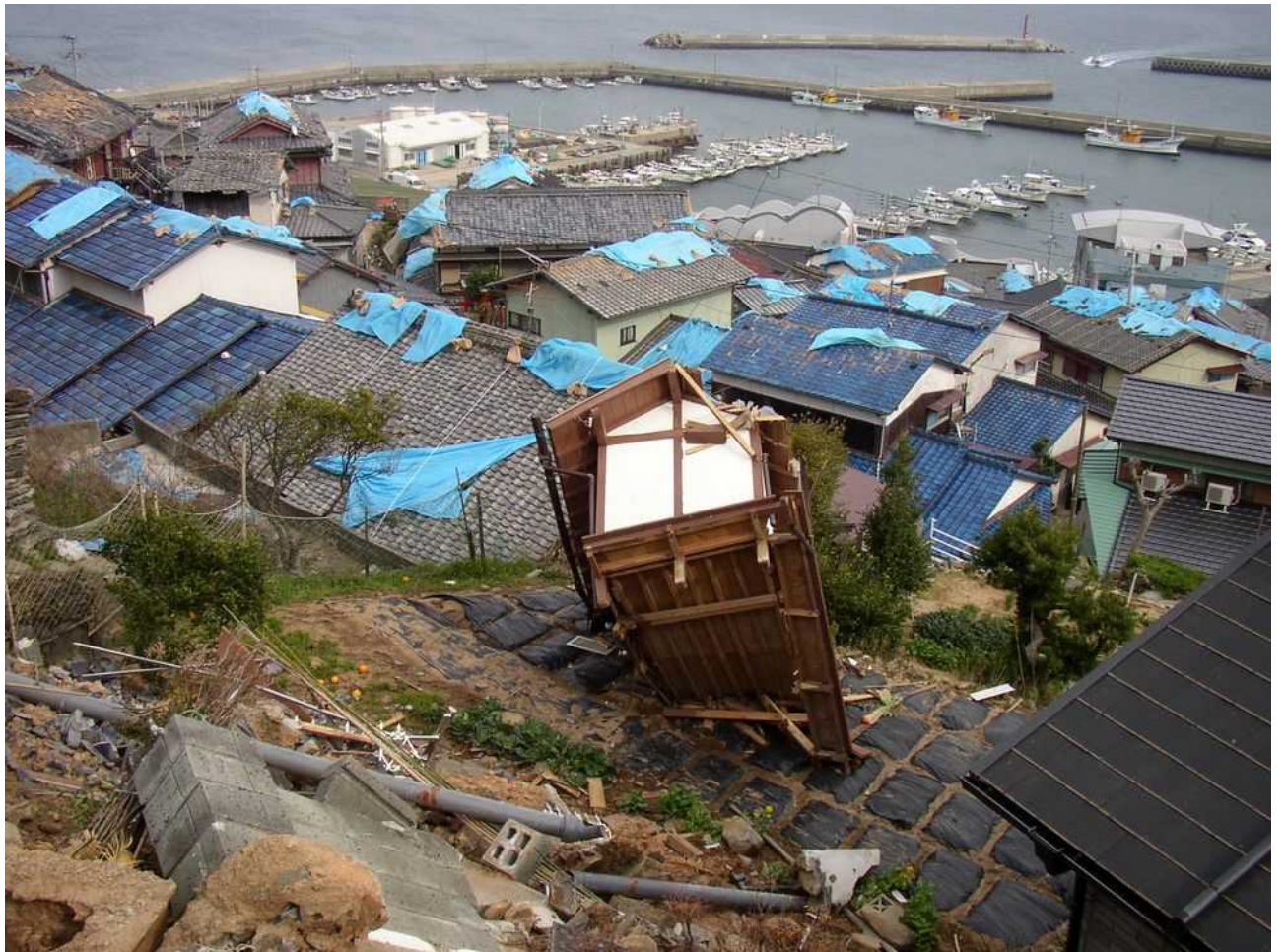
玄界島南側斜面の家屋の損壊状況（宅地崩壊により、家屋が下の畑に落下している）
