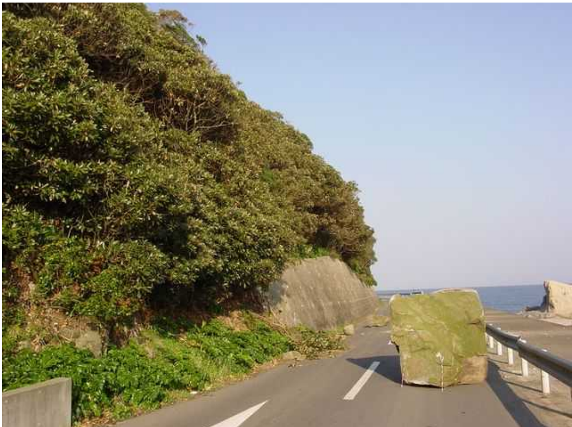
志賀島東側斜面の落石状況
