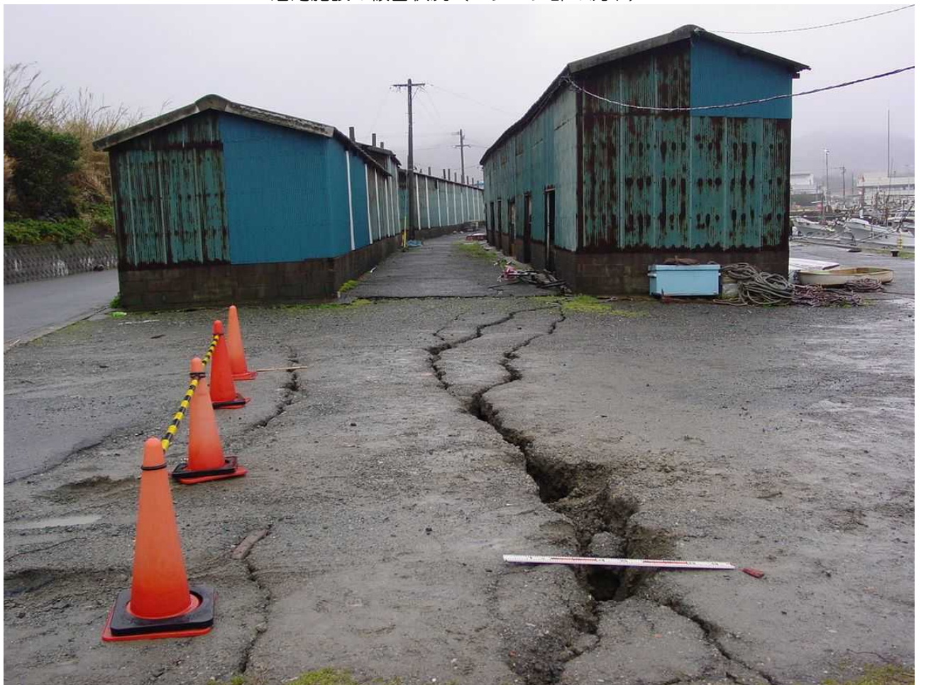
港湾施設の被害状況（護岸の海側へのはらみ出しに伴う開口亀裂）
