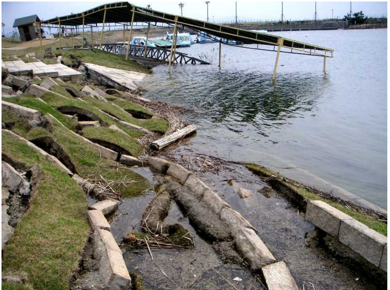
側方流動に伴う護岸の被害状況
