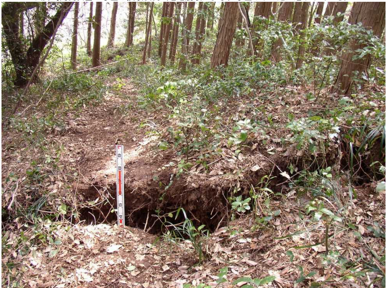
玄界島山頂付近に見られる開口亀裂（当該箇所は地すべり頂部付近に位置している）
