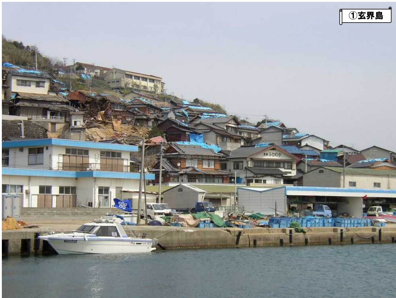
玄界島南側斜面の宅地崩壊状況（崩壊斜面には緩いマサ土が露出している）
