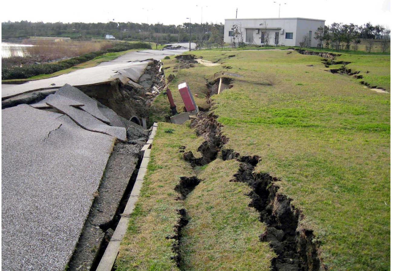
側方流動に伴う亀裂の拡大状況
