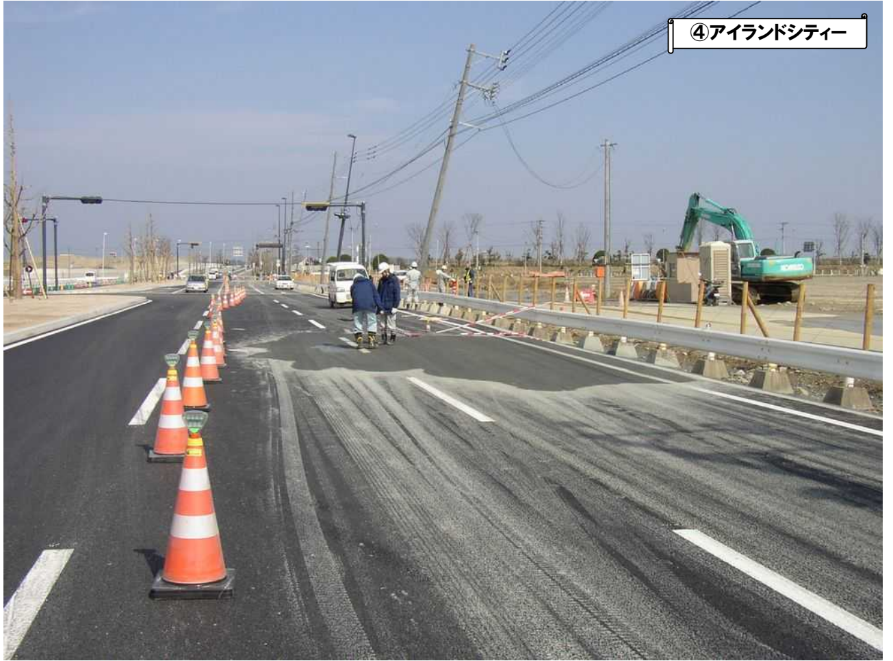
液状化に伴う噴砂、電柱の傾倒
