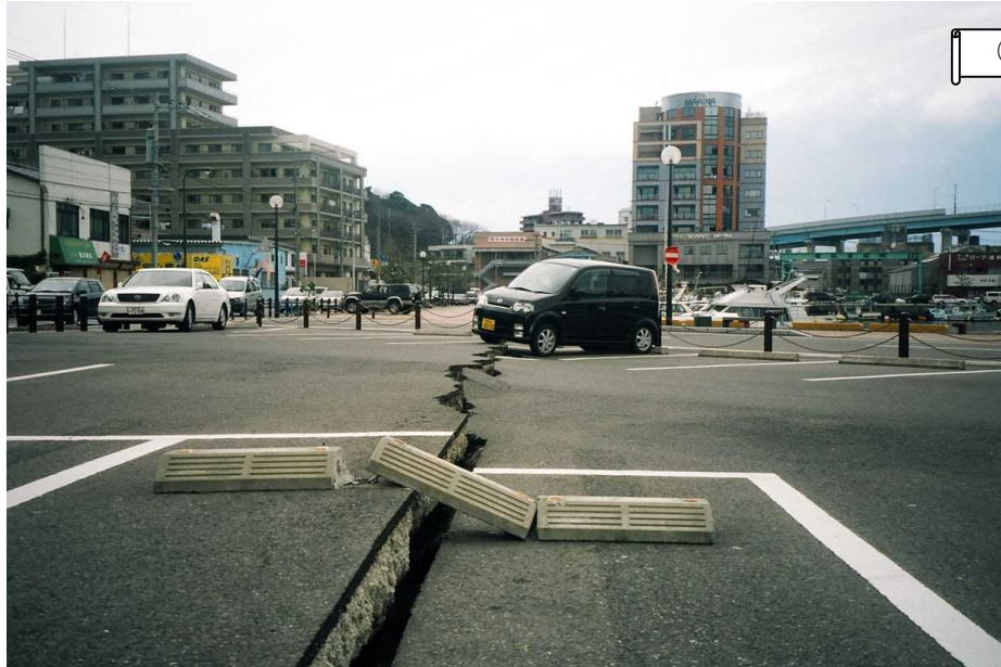
海側埋立地盤の沈下
