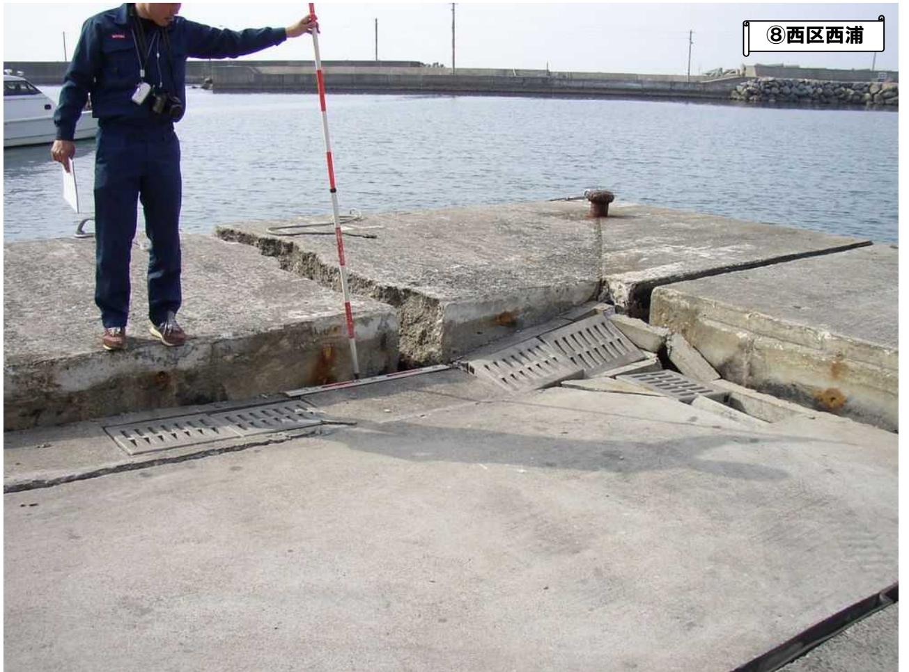
港湾施設の被害状況（エプロン部の沈下）
