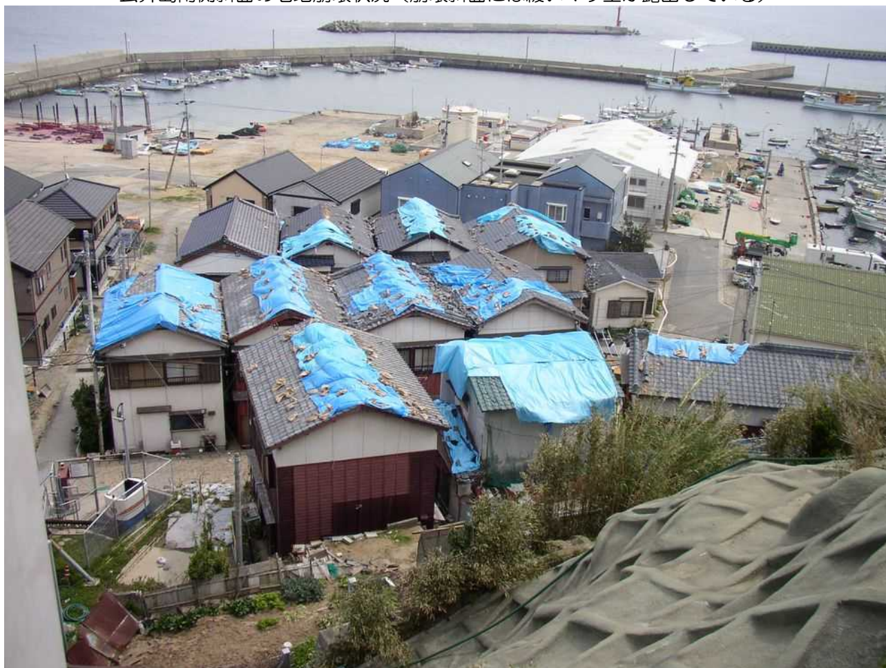
玄界島南側斜面直下の家屋の損壊状況（被害は古い家屋に集中している）
