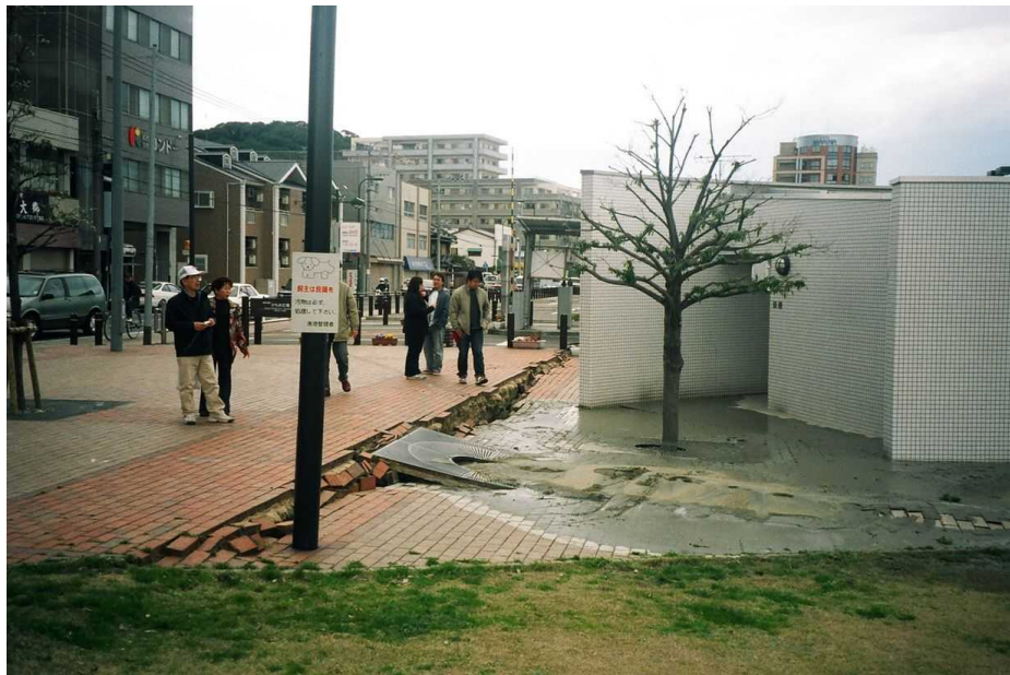
沈下に伴う段差、液状化に伴う噴砂
